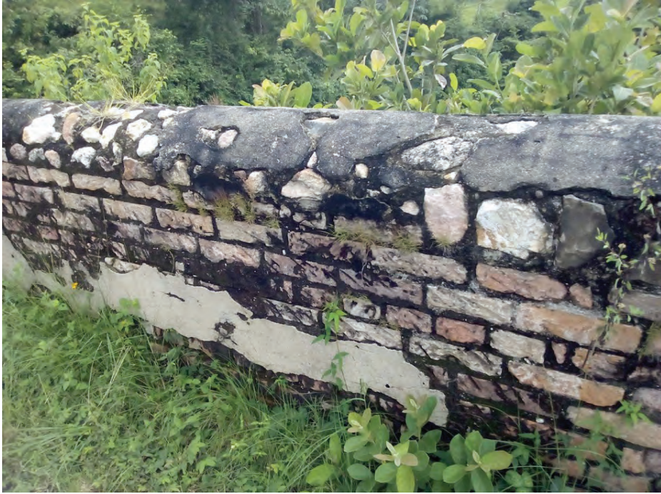
Detalle del pretil del puente. Foto: Eduardo Rivas.
